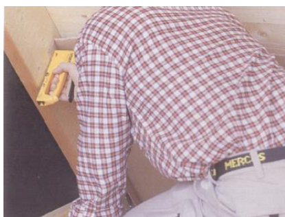
ISOVER tuulesuunaja paigaldus klambripüstoliga
