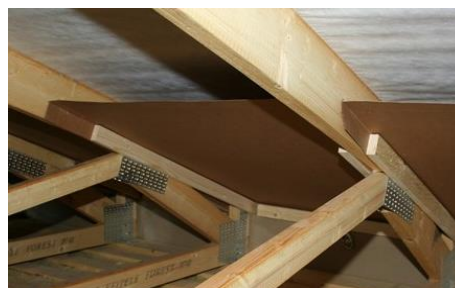
Paigaldatud ISOVER tuulesuunaja
