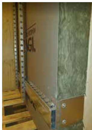
Joonis 10. SerpoVent U seinakandurid A-B ning SerpoVent profiilid OL-33 soojustusele ja CLT-plaadile paigaldatuna
