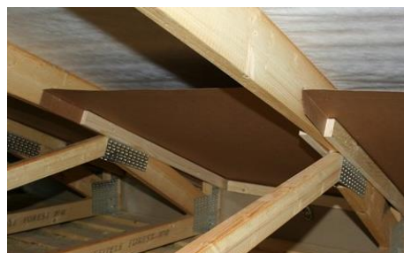
Paigaldatud ISOVER tuulesuunaja
