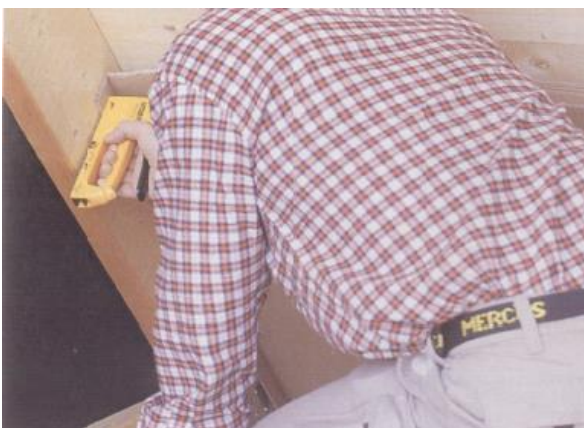
Isover tuulesuunaja paigaldamine
