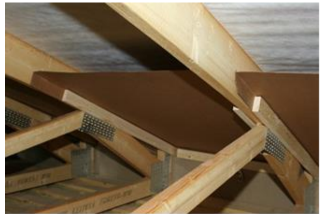
Foto paigaldatud Isover tuulesuunajast
