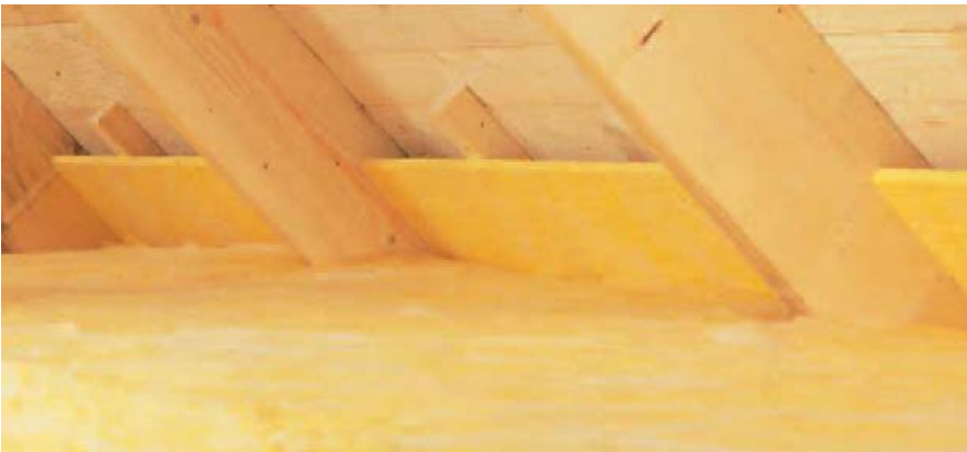
Foto mineraalvillast tuuletõkkeplaatidest tehtud tuulesuunajad
