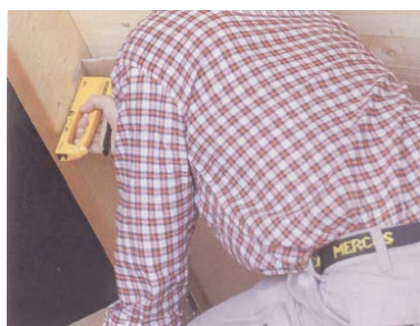
Установка направляющей потока воздуха ISOVER с помощью строительного степлера
