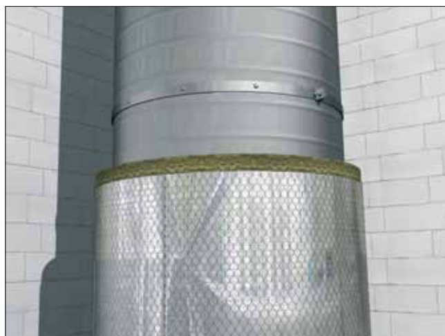
Ümmarguse ristlõikega püstkanalite paigalduspõhimõte.
