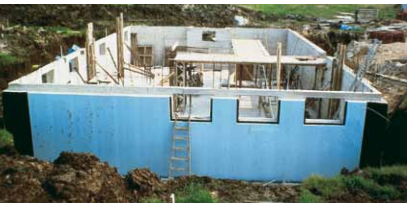
STYROFOAM 250 SL-A-N soojustusplaatide kasutamine keldriseinte soojustamisel
