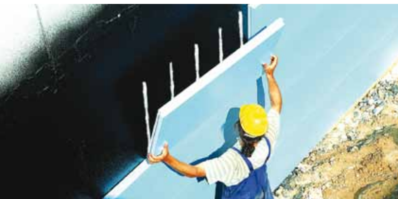
STYROFOAM plaatide paigaldus keldri seinale polüuretaanliimiga.
